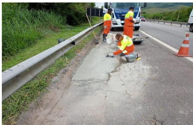
Figura 4.6 Via Lagos – Recuperação de Sarjeta - Km 11+700 Sul
