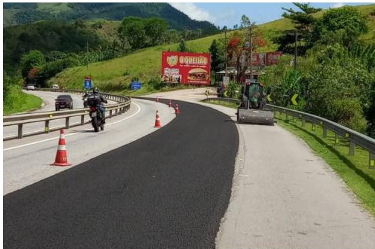
Figura 6.16 Via Lagos - Micro revestimento asfáltico à frio (15mm) - Km 08+000 Norte
