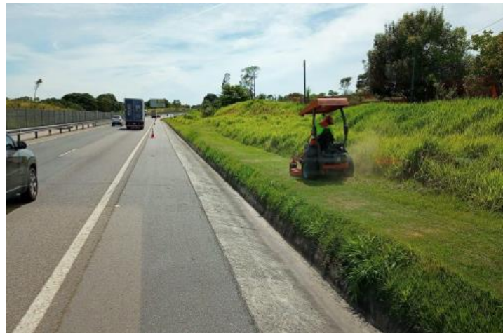
Figura 6.11 Via Lagos – Roçada Mecânica - Km 33+000 Norte
