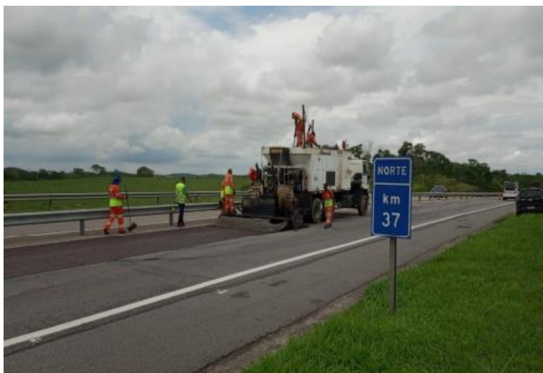
Figura 6.17 Via Lagos - Micro revestimento asfáltico à frio (15mm) - Km 37+000 Norte
