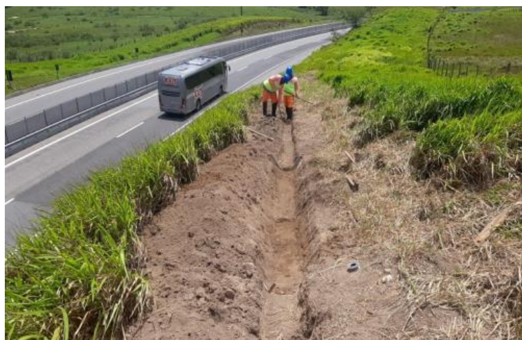
Figura 6.15 Via Lagos – Implantação drenagem superficial - km 38+900 Norte
