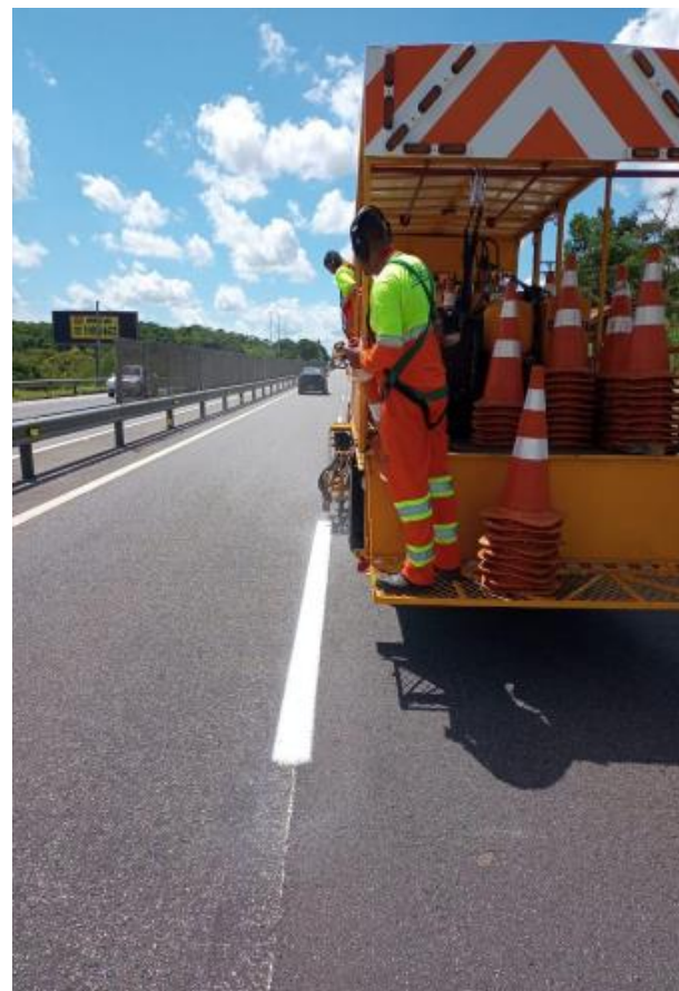
Figura 4.3 Via Lagos – Pintura de Faixas - Km 27+000 Sul
