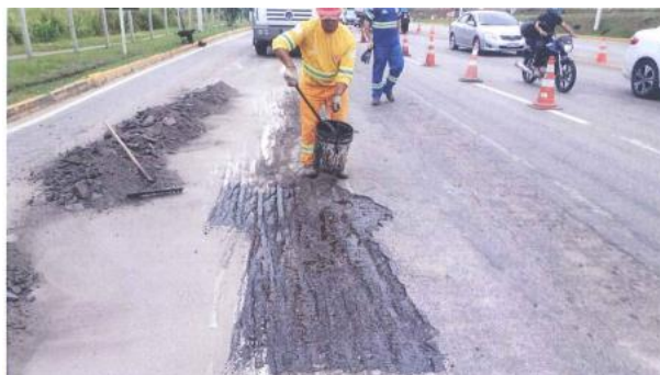
Figura 6.23 Rota 116 – Recuperação de pavimento - km 122
