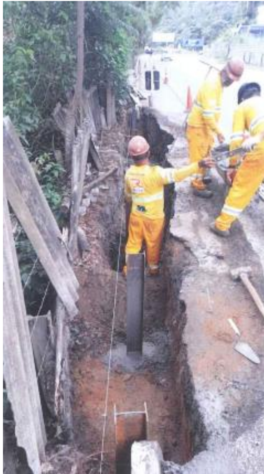
Figura 6.27 Rota 116 – Obra emergencial de contenção – km 105.3
