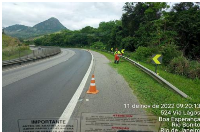
Figura 6.7 Via Lagos - Roçada Manual - Km 10+000 Sul
