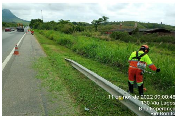
Figura 6.9 Via Lagos – Roçada Manual - Km 12+000 Sul
