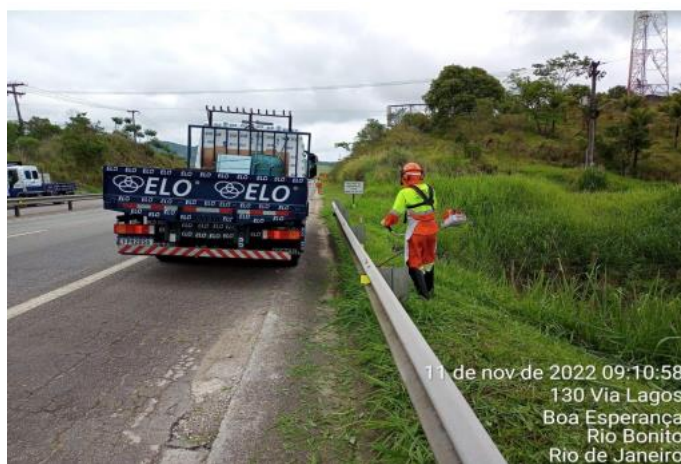
Figura 6.8 Via Lagos – Roçada Manual - Km 11+000 Sul
