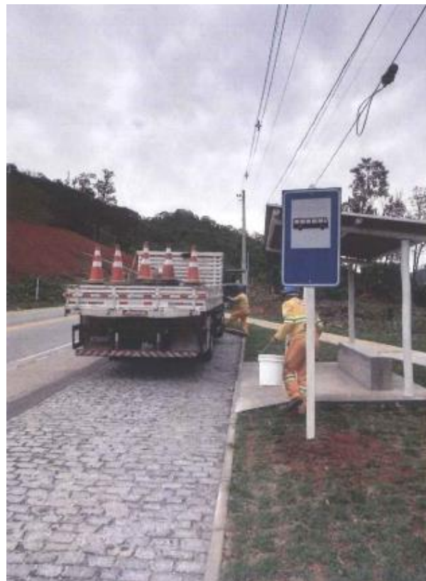
Figura 6.21 Rota 116 – Sinalização vertical – km 94 ao km 98
