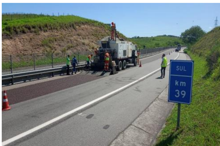
Figura 6.18 Via Lagos - Micro revestimento asfáltico à frio (15mm) - Km 39+000 Sul
