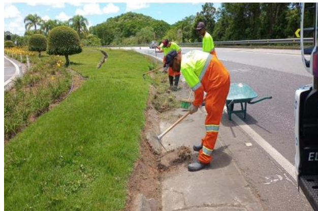
Figura 4.5 Via Lagos – Limpeza de Sarjeta - Km 22+500 Norte
