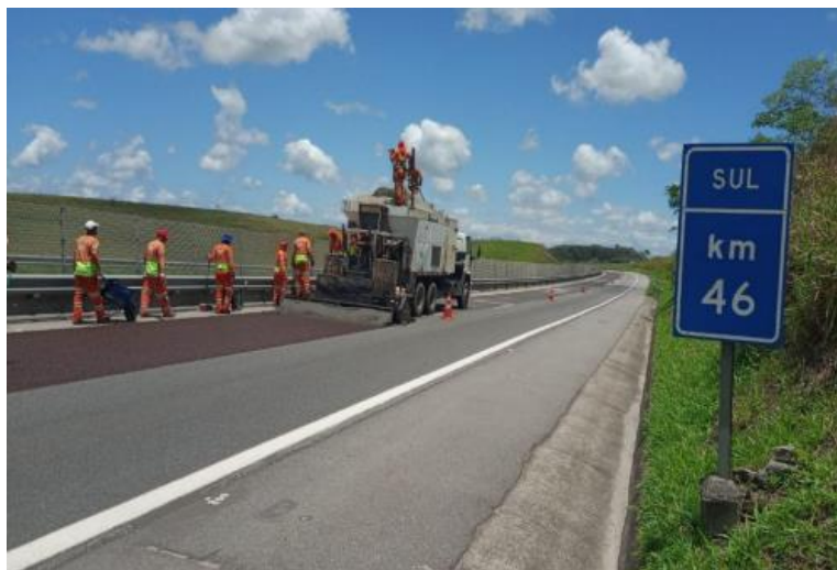
Figura 6.19 Via Lagos - Micro revestimento asfáltico à frio (15mm) - Km 46+000 Sul
