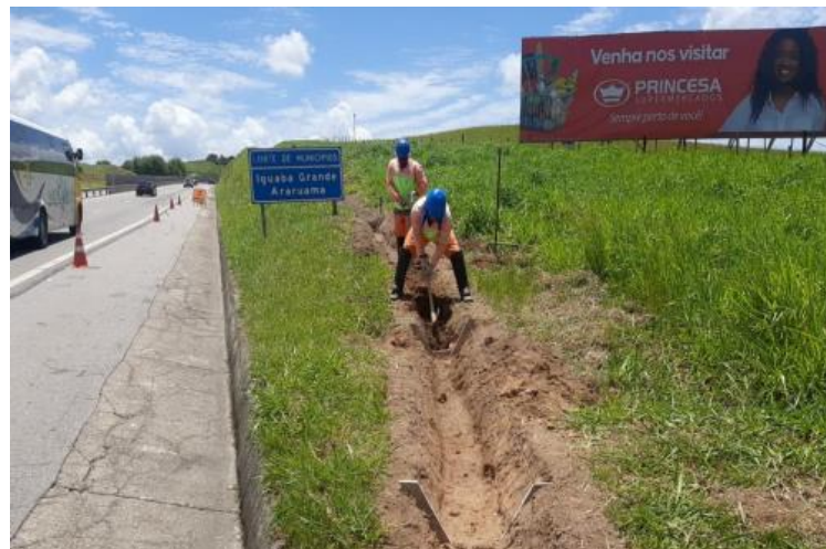
Figura 6.14 Via Lagos – Implantação drenagem Superficial - Km 45+400 Norte
