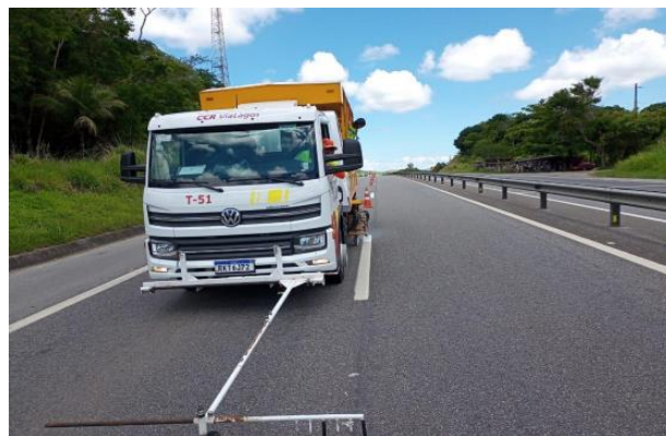
Figura 6.2 Via Lagos – Pintura de Faixas - Km 25+000 Norte
