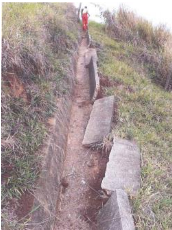
Figura 6.24 Rota 116 – Limpeza e Recuperação de drenagem – km 118-123
