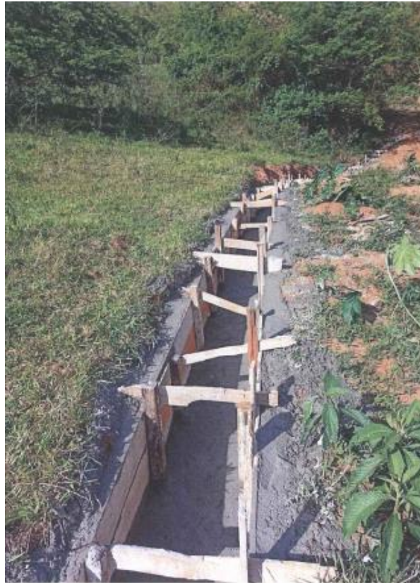
Figura 6.25 Rota 116 – Implantação de drenagem – km 133.5
