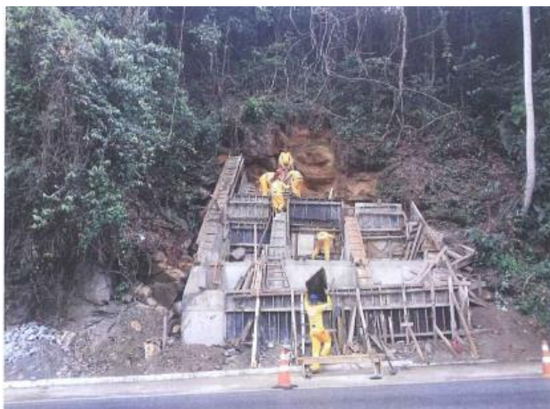
Figura 6.22 Rota 116 – Obras emergenciais de contenção – km 44.1 Sul
